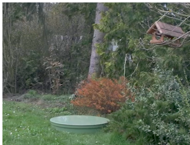
Instalación de la EDAR PRIME 7
